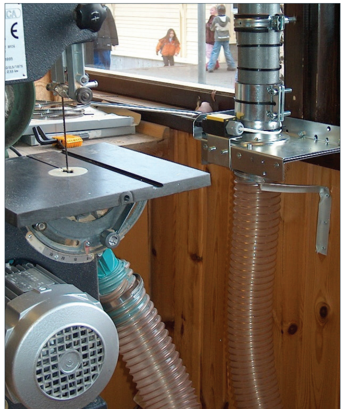
Udsugning direkte ved maskine.
