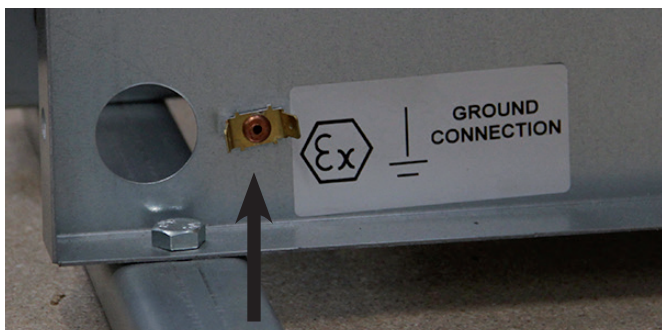
Tilslut jordkablet til ventilatoren
