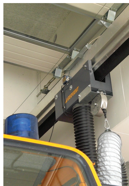
Geovent slædekanal her vist med trykføl-som afkaster, som slæden aktiverer.
