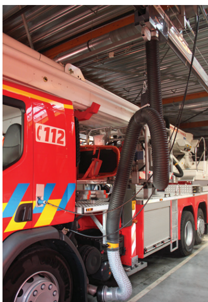
Geovent slædekanal med automatisk frakobling til brug hos brandvæsenet. Her vist med elektronisk afkobling
