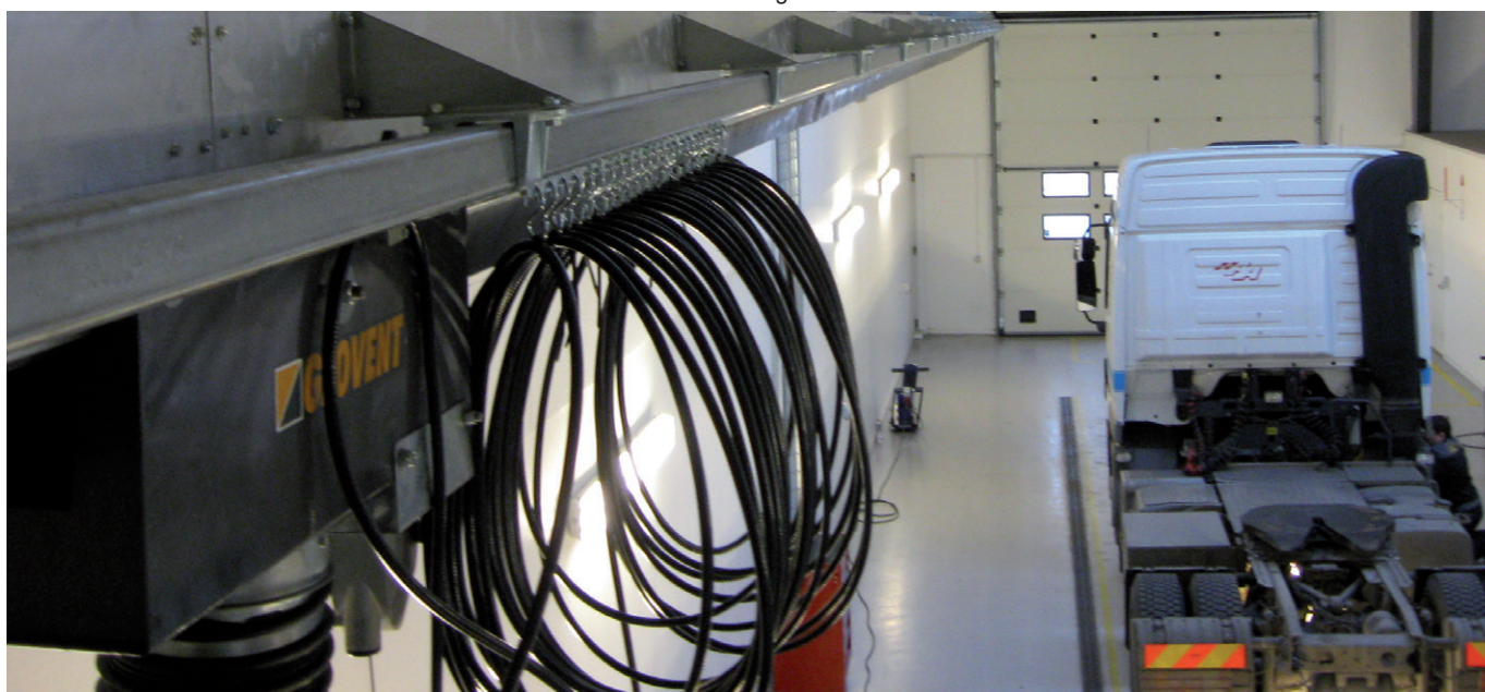
Geovent slædekanal monteret i en synshal med trykluffforsynet mundstykke for automatisk afkobling.
