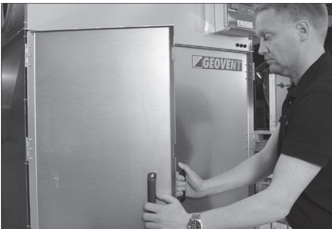
2. Die Tür öffnet sich (der Filter kann ausgetauscht werden)
