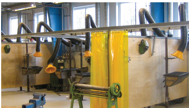
Bras Wing \phi 160mm 3m installés dans un lycée technique. Ils comprennent des dispositifs de contrôle automatique pour le démarrage / l'arrêt automatique du ventilateur et du régulateur de moteur.
