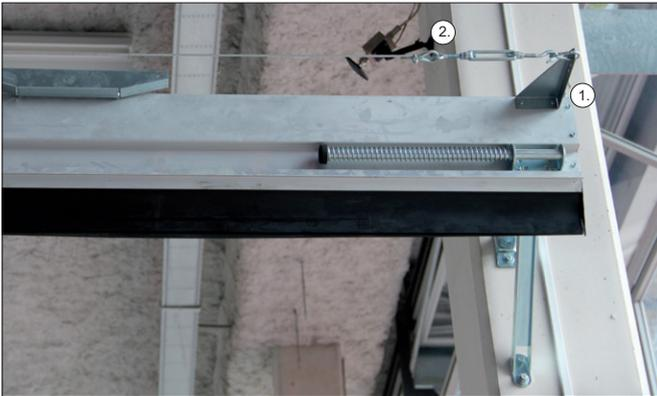
1: Fixation des supports de montage pour le rail. Plus le rail (fil) est long, plus les supports doivent être solides. Ils doivent être ancrés aux deux extrémités du rail. Le point de fixation approprié peut être un chevron en béton ou un mur.
